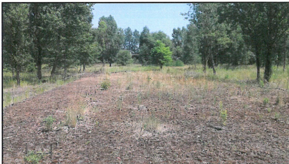
Fot. 2. Widok na fundamenty - pozostałości po niezrealizowanej inwestycji
